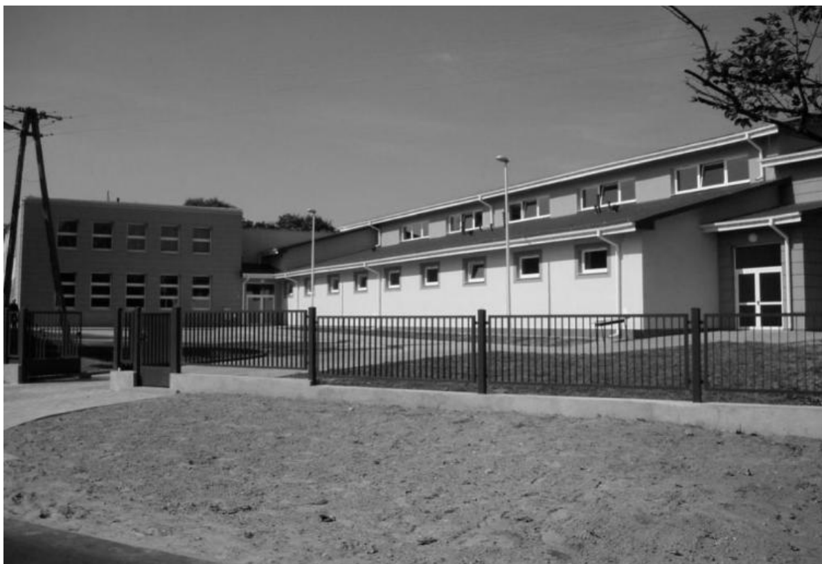
Nowa sala gimnastyczna i zmodernizowany budynek szkoły w Białopolu, 2006 r.
