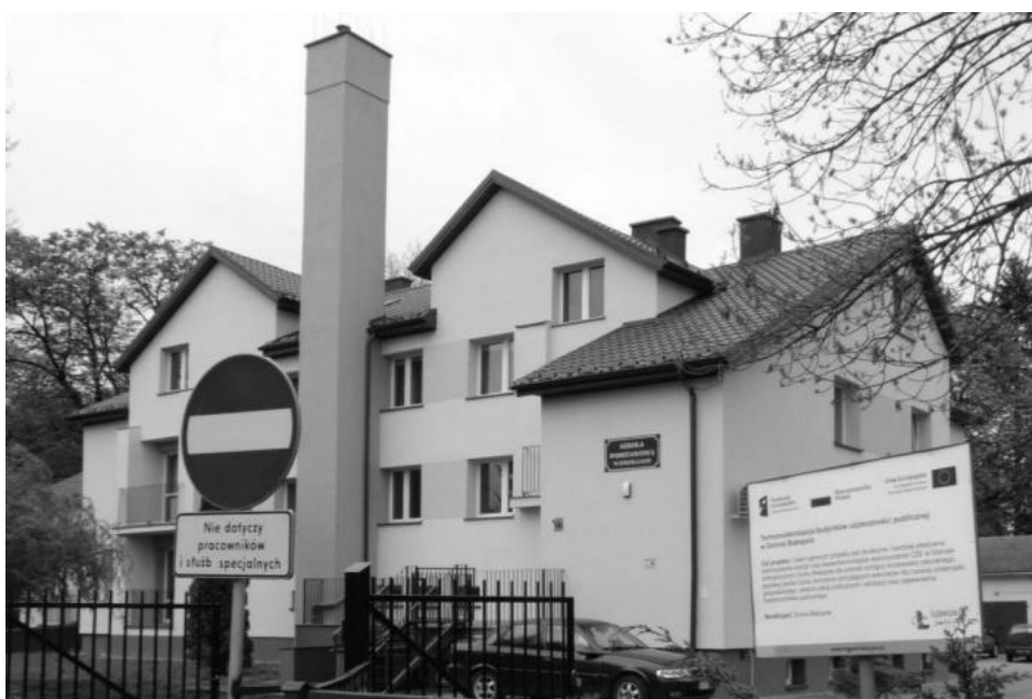
Termomodernizacja budynku Szkoły Podstawowej w Strzelcach
