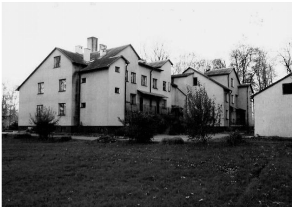
Budynek Szkoły Podstawowej w Strzelcach przed modernizacją.
