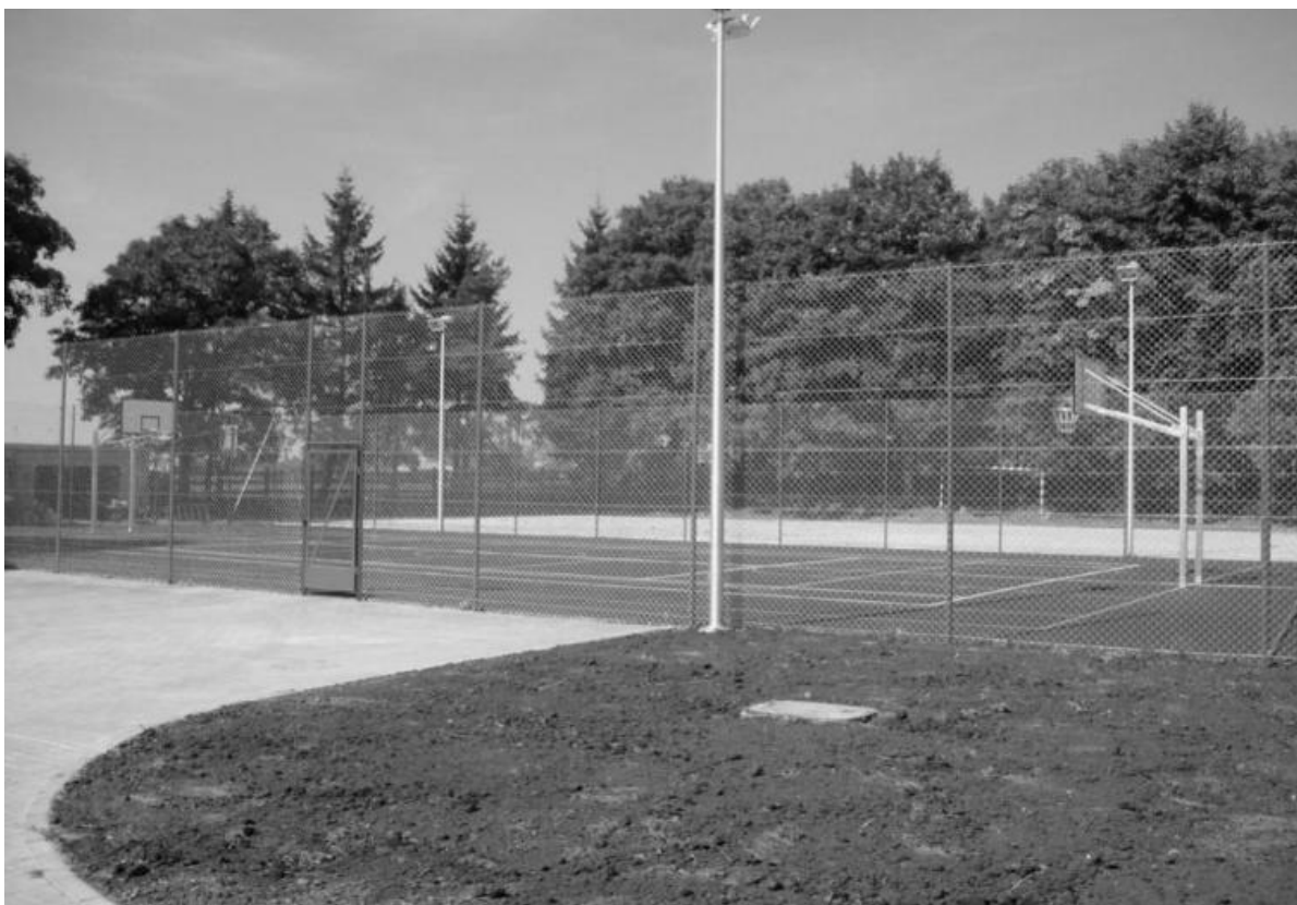
Nowe boisko wielofunkcyjne o nawierzchni tartanowej do gry w koszykówkę, siatkówkę i tenisa ziemnego.
