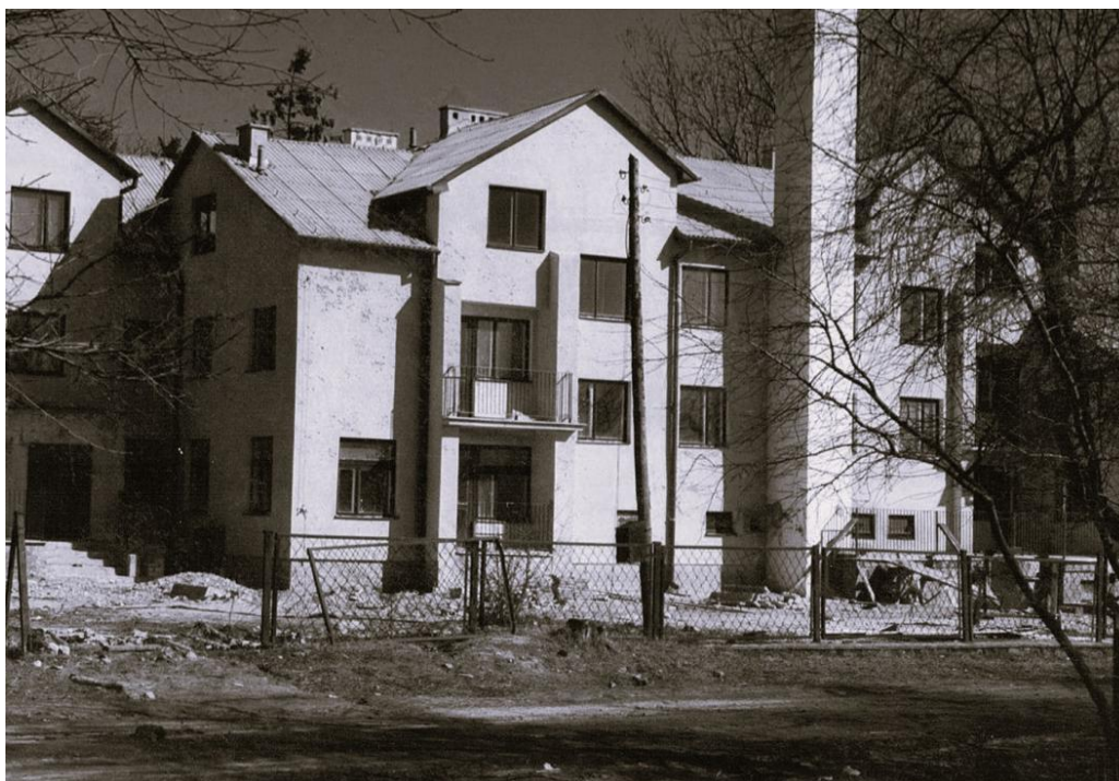
Budowa nowego budynku-domu nauczyciela
