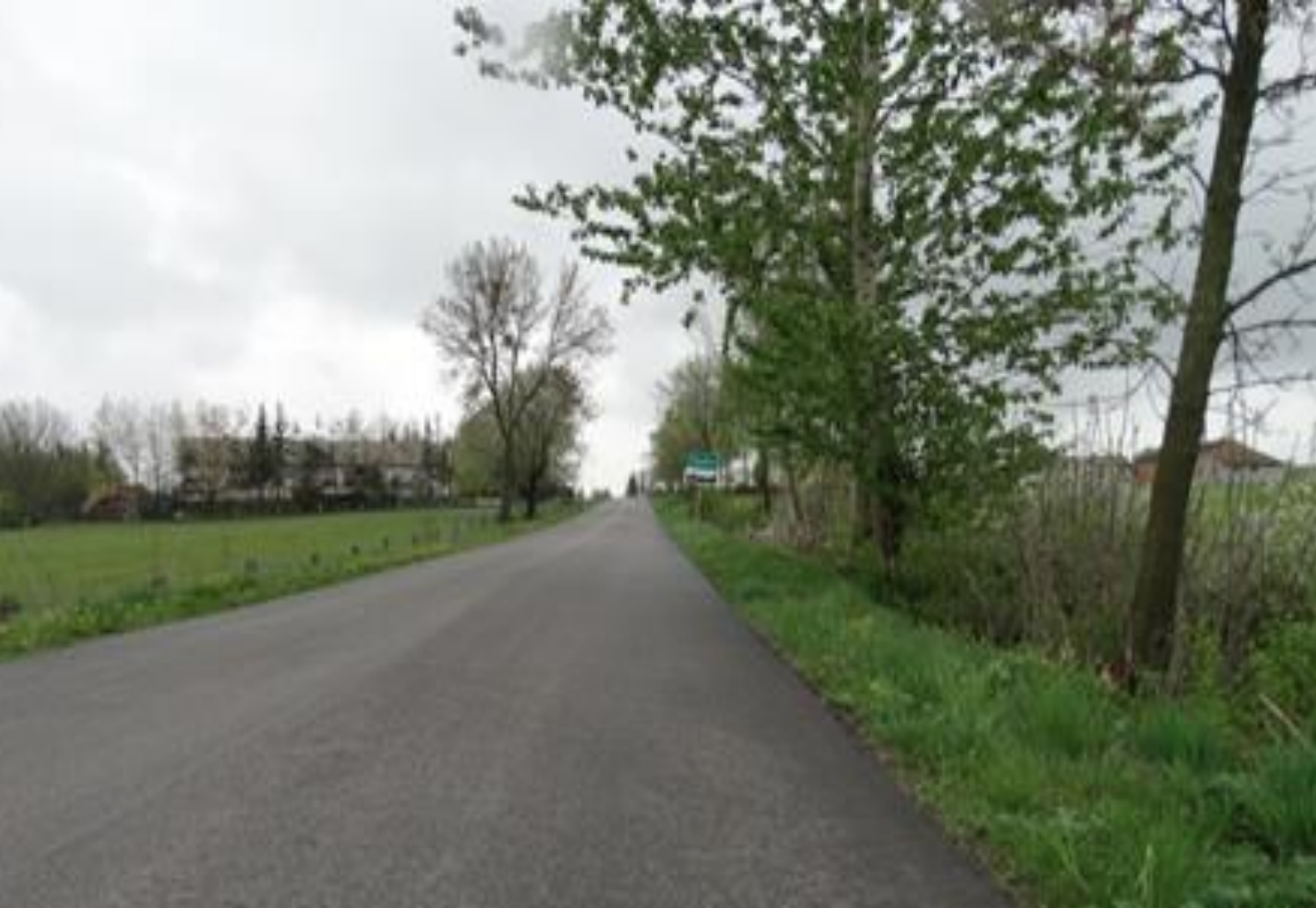
Zmodernizowana droga powiatowa Raciborowice - Strzelce, 2018r.
