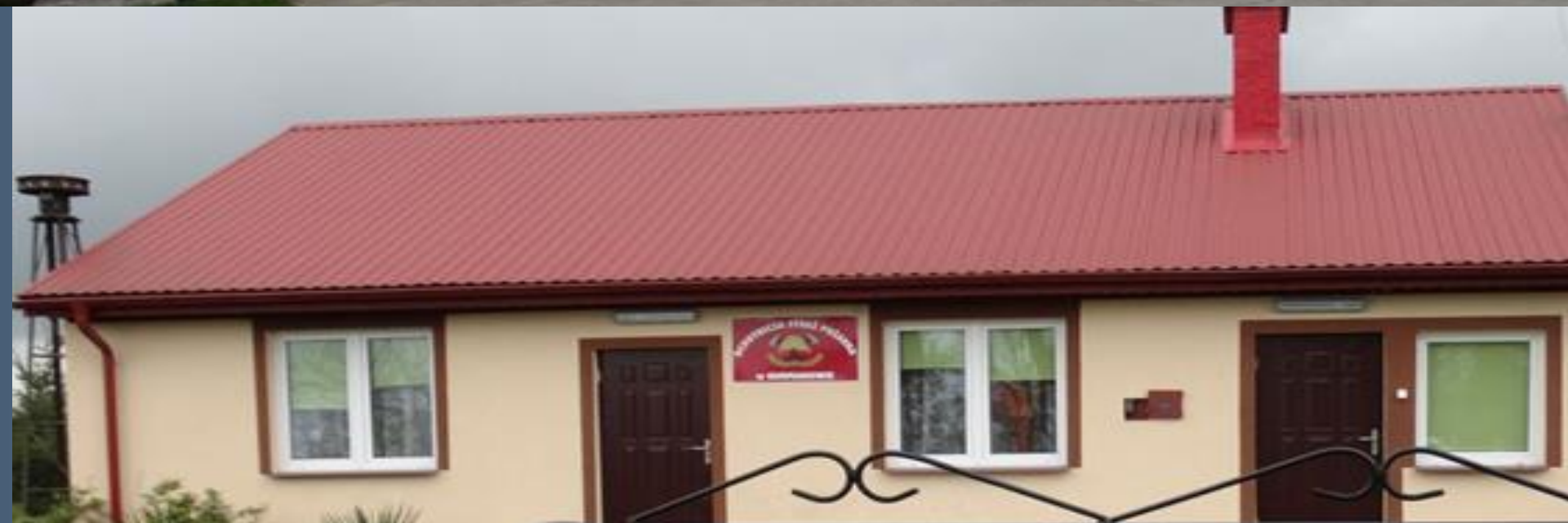
Termodenizacja świetlic w Białopolu i Kurmanowie, 2018r.
