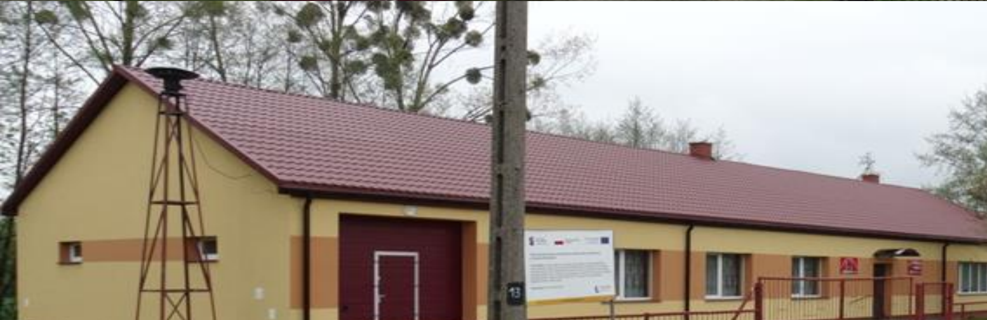
Termomodernizacja świetlic w Buśnie i Raciborowicach Kolonii, 2018r.
