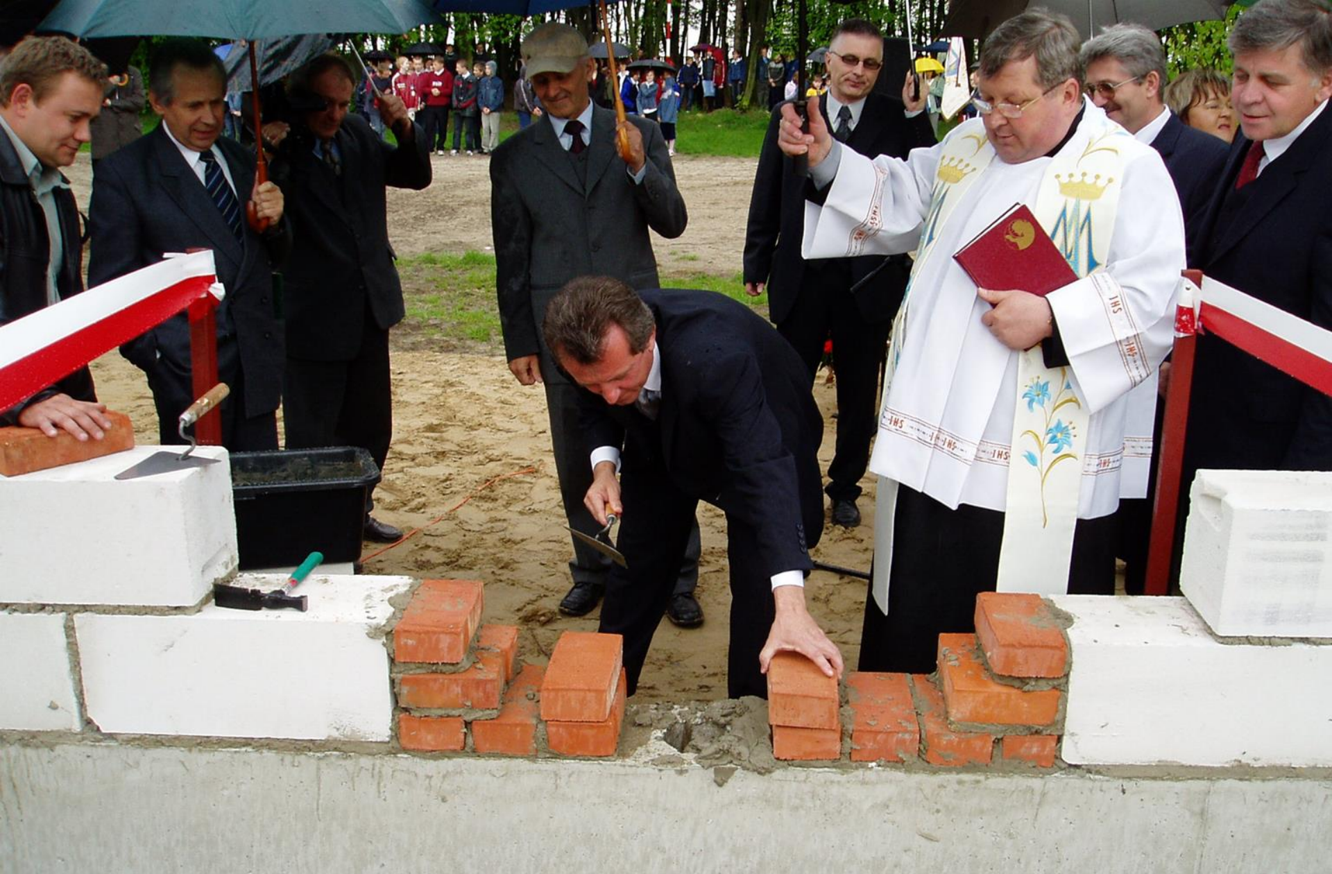
Wmurowanie kamienia węgielnego pod budowę sali gimnastycznej, 15 maja 2005r.
