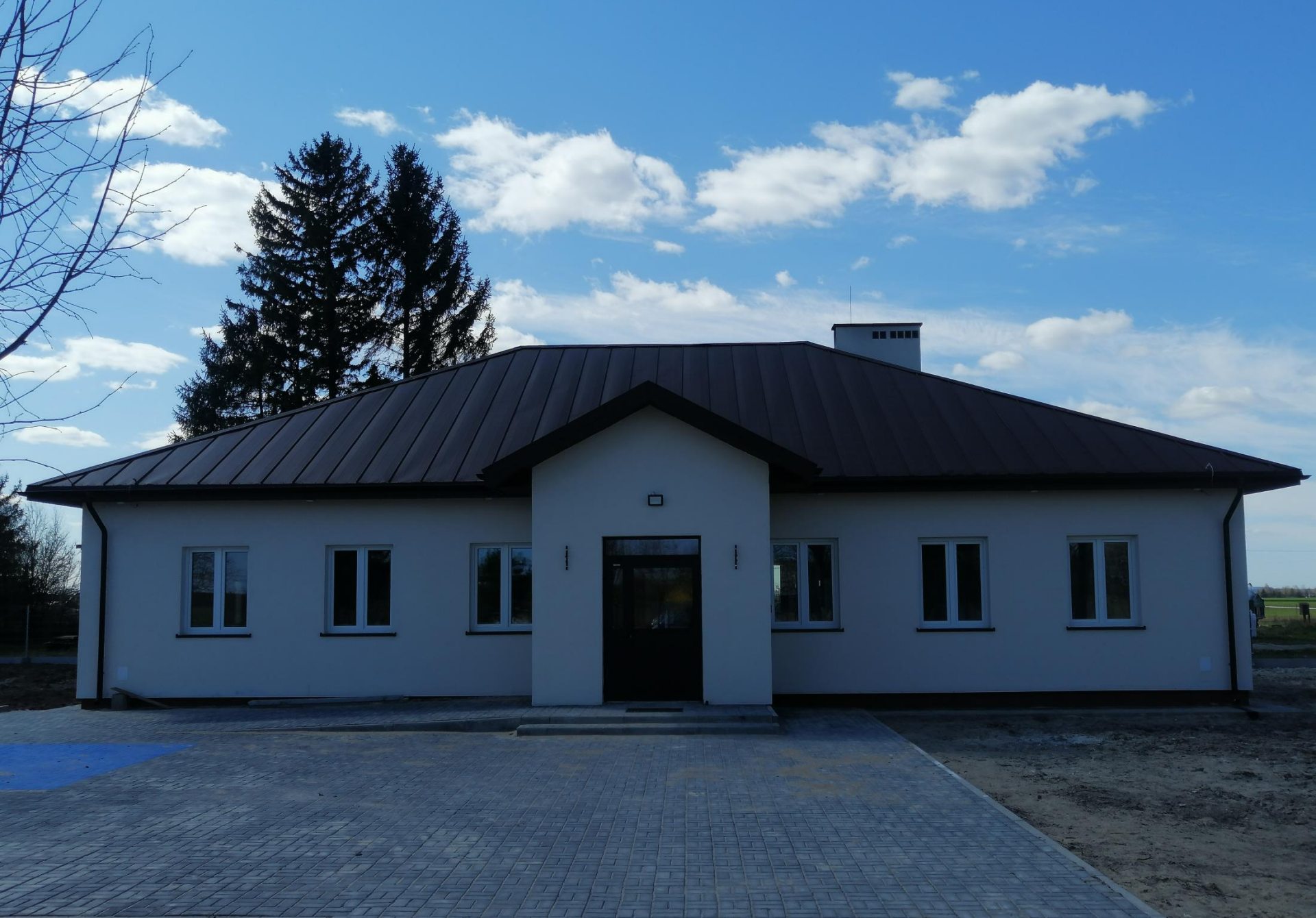
Nowa świetlica wiejską w Strzelcach Kolonii, 12 marca 2020r.
